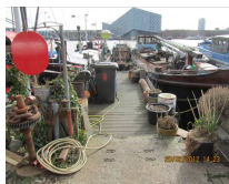
Voorbeeld niet te inspecteren steiger
